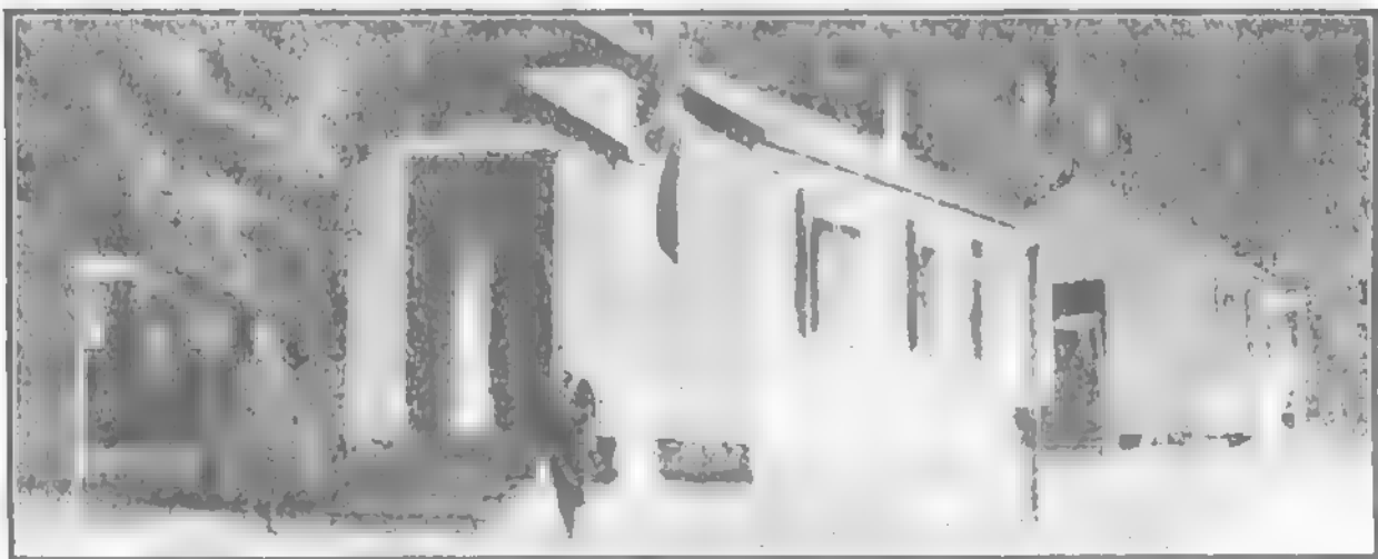
行宮用木構造。可以隨時拆卸。數小時即能搭成。
